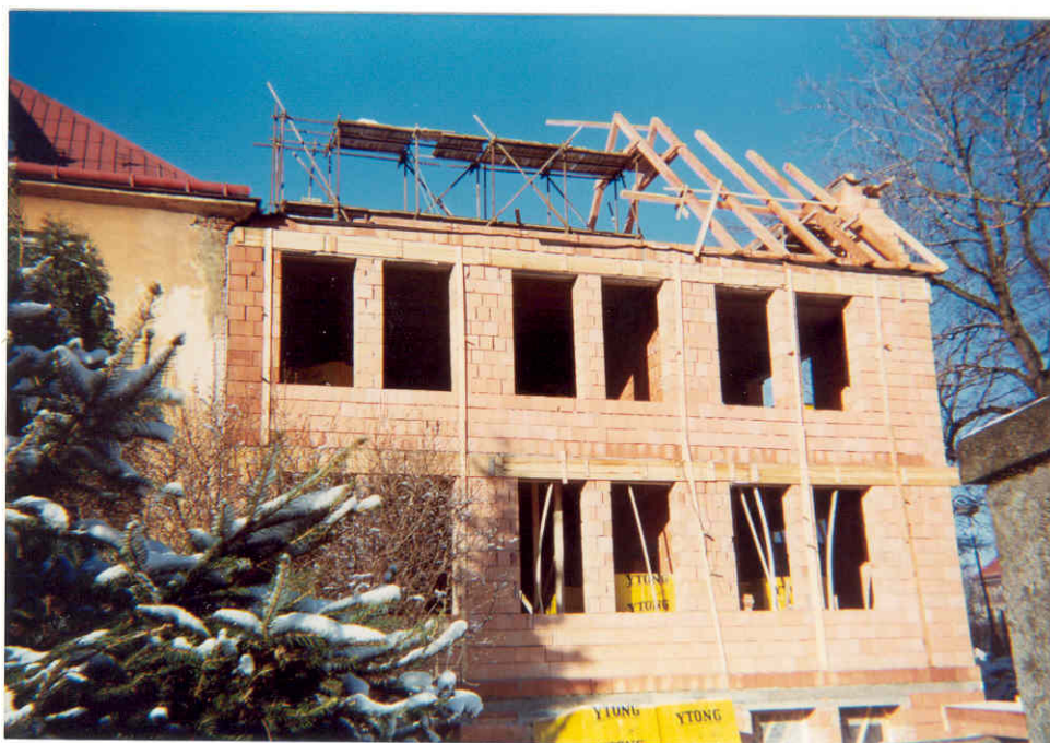
Přístavby budovy OHS Bruntál (1998)
