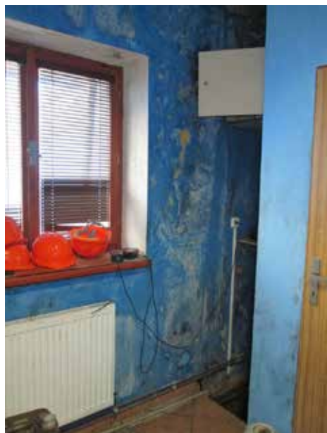
Obrázek 25 Pohled na nevyhovující stavebně-technický stav pracoviště
