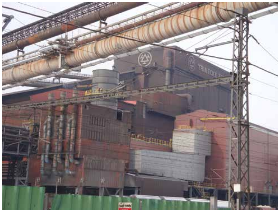
Obrázek 22 Pohled na instalované odprášení v TŽ
