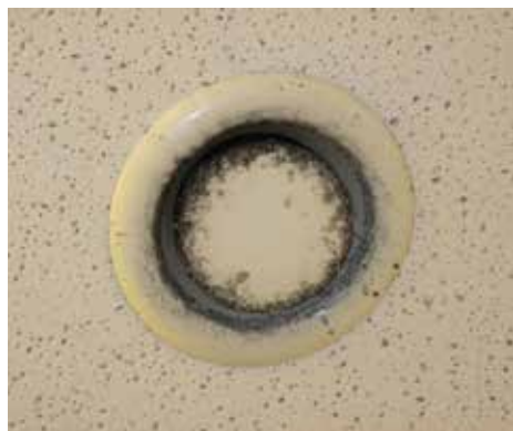
Obrázek 28 Zanesení vzduchotechnických vyústek
