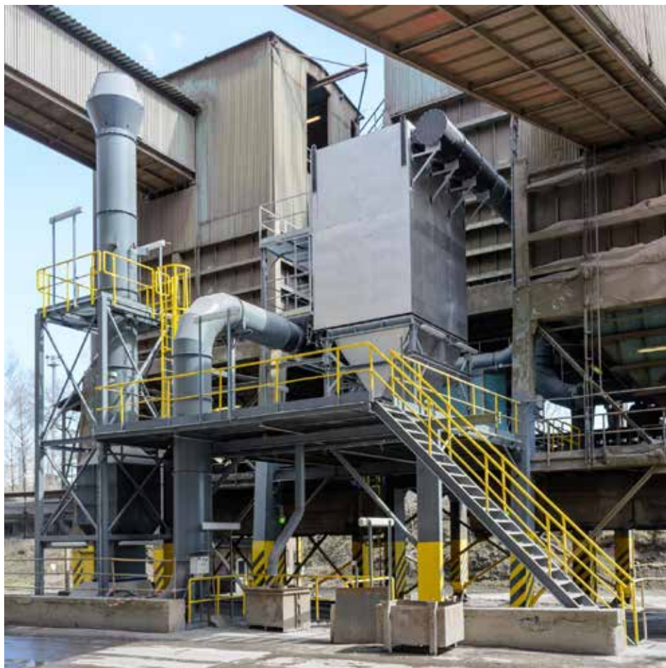
Obrázek 27 Filtrační stanice mlýnice strusky Třineckých železáren
