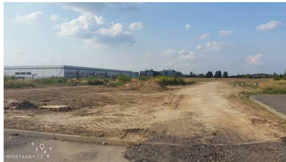
Obrázek 28 Stavba haly pro strojírenský výrobní provoz, zemní práce, srpen 2018
