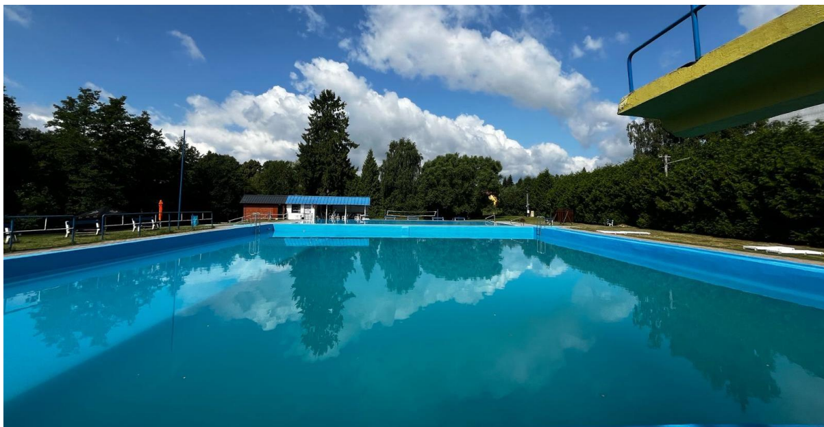
Nádrž ke koupání Klimkovice, okres Ostrava, Foto: KHS
