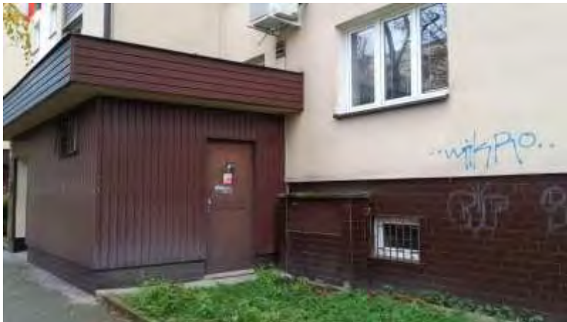
Vstup B, rozvaděč
