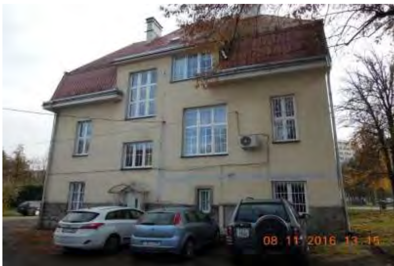
Hlavní budova – zadní průčelí
