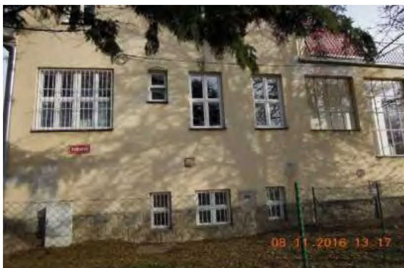
Hlavní budova – pravá strana
