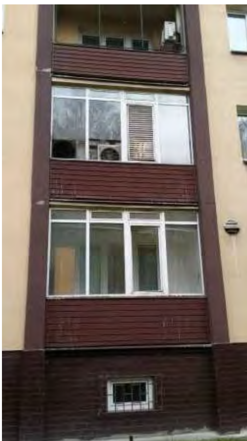
Zadní průčelí - balkony
