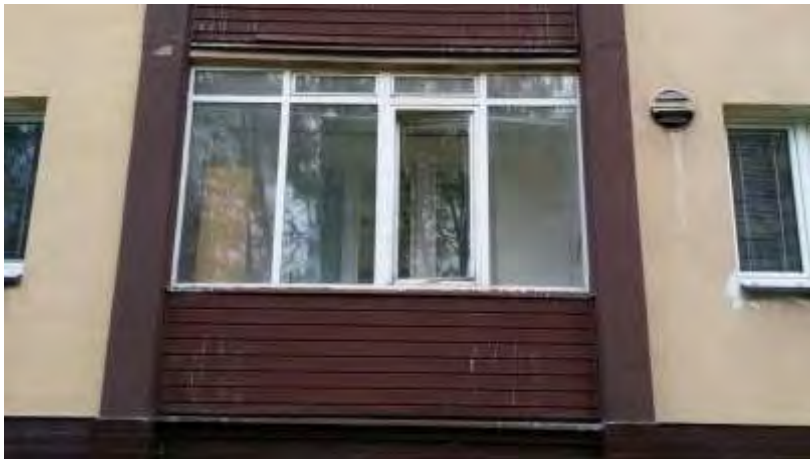
Balkony – zasklení, obložení
