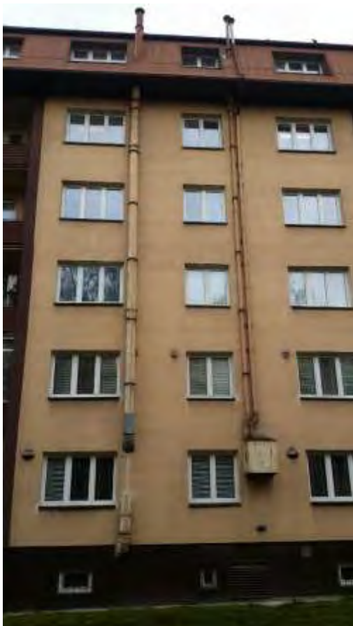
Zadní průčelí - vzduchotechnika
