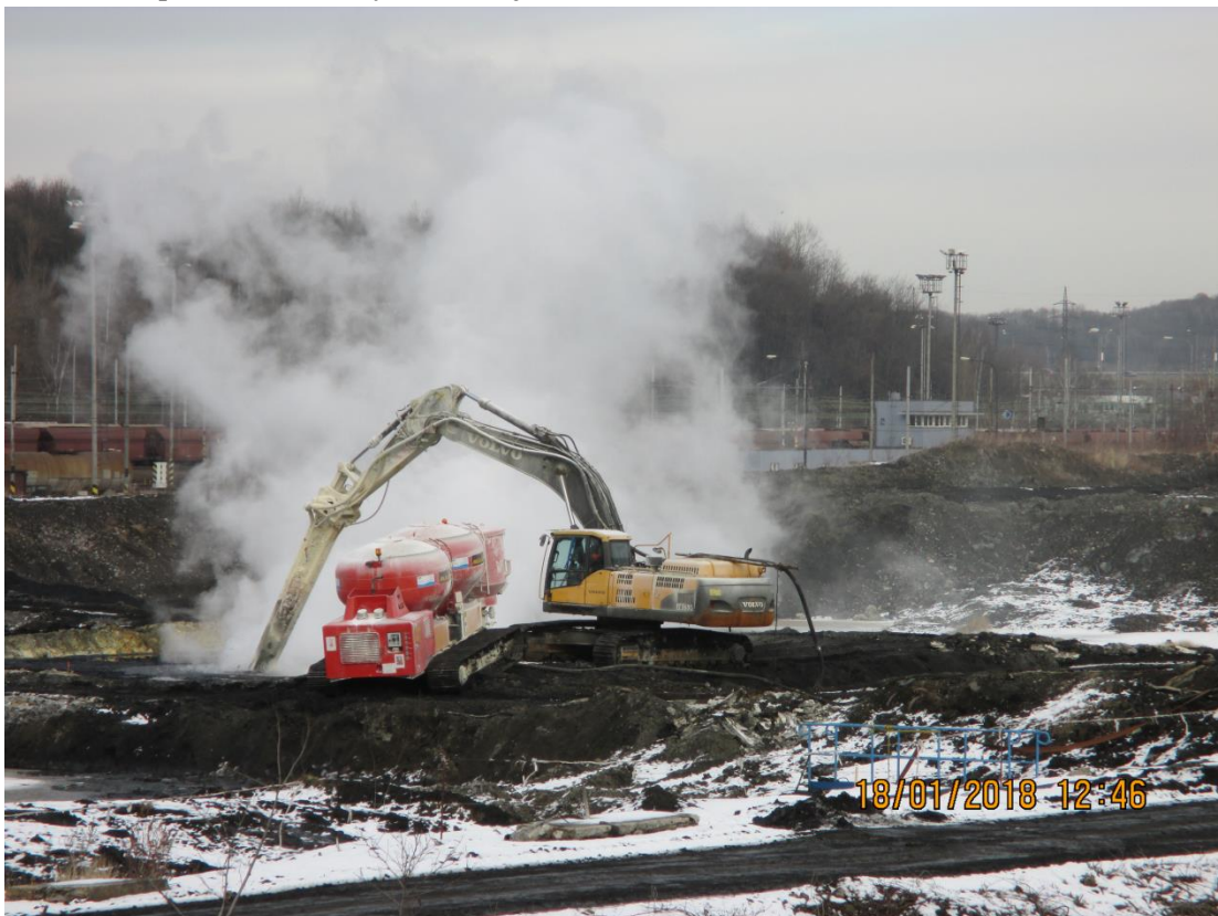
Proces zavápňování odtěžených kalů v jímce
