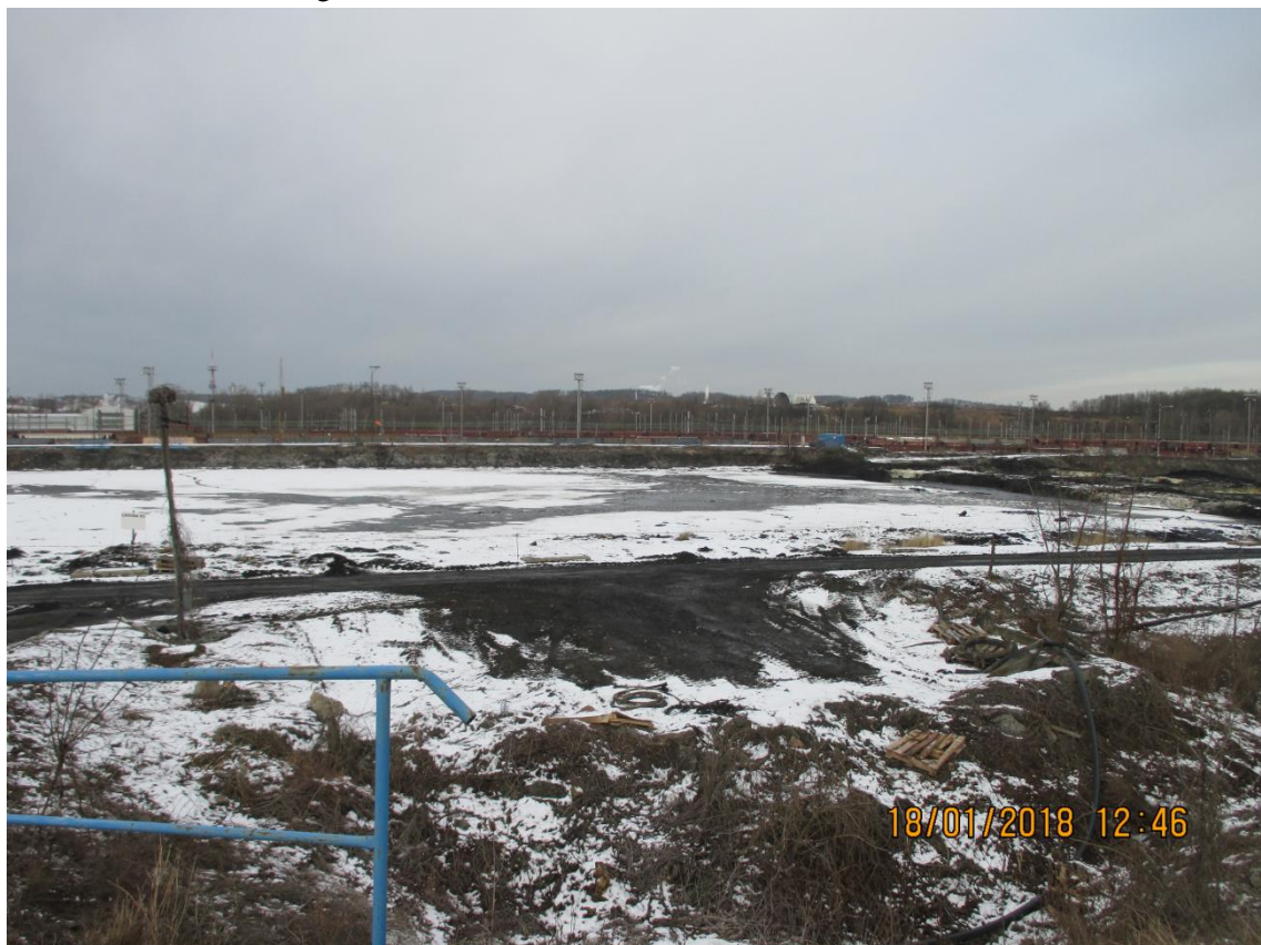
Pohled na sanovanou lagunu
