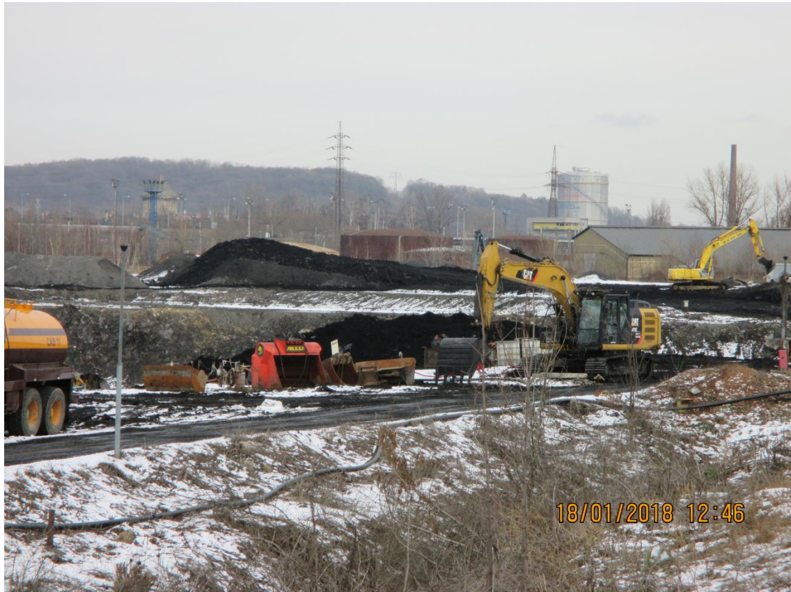
Pohled na úložiště zpracovaných kalů
